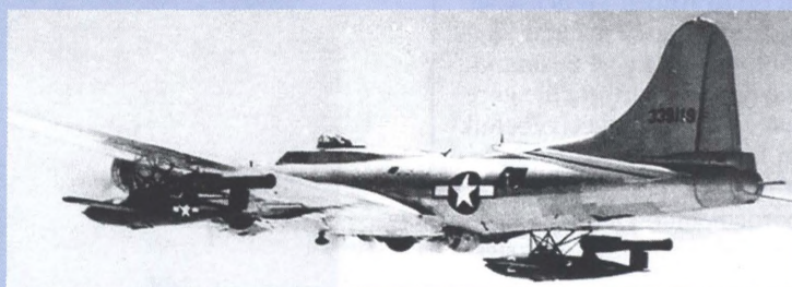
B-17 bombefly med to JB-2 krydsermissiler under vingerne. I pressen blev de omtalt som JD-2 og det amerikanske svar på V-2-bomberne, men missilet havde faktisk betegnelsen JB-2, Republic/Willys-Overland V-1, og var en videreudvikling af Nazi-Tysklands V-1 bomber.
