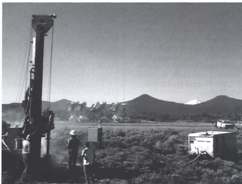
Arbejdet med fundamentet til den første ATA parabol er i fuld gang.
