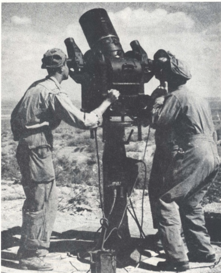
Foto-theodolit station på White Sands forsøgsområdet. En foto-theodolit består af et kikkert-linse-kamera, der kan hæves og sænkes i højden og drejes horisonten rundt. Med dette instrument kan man på samme tid filme balloner (eller raketter etc.) og registrere deres højde og kurs.
