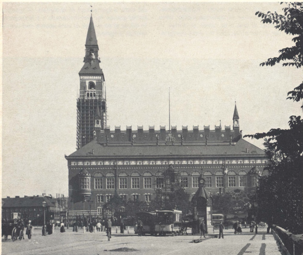
Københavns Rådhus – før UFOer hed UFOer. Billedet er taget i august 1899, inden byggeriet var afsluttet. Bemærk, at tårnuret endnu ikke er monteret.
