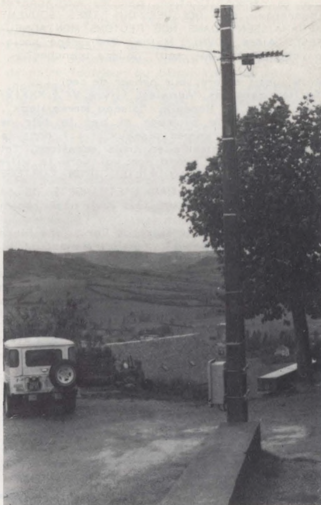
Le poteau d'éclairage et sa boîte que l'on voit sur les autres clichés.
