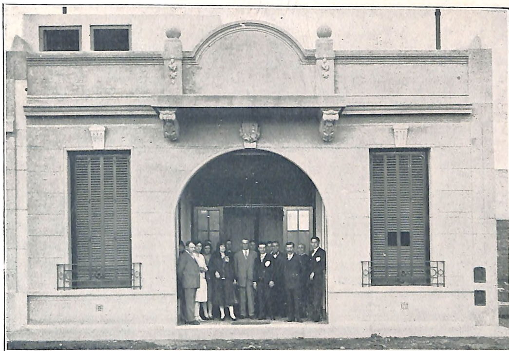
Frenta del nuevo edificio.
